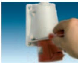
4) Si posiziona il coperchio sulla base fissandolo con le 4 viti a passo rapido in dotazione
